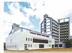
ポートアイランドキャンパス 体育ホール完成
