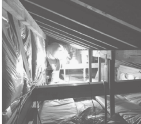
図1 屋根裏の写真
